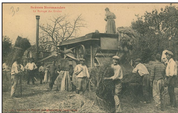
4. Les premières batteuses mécaniques
