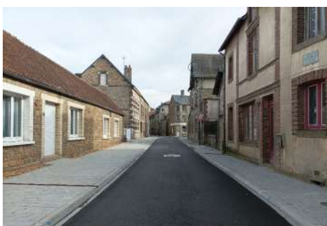
Un effet couloir des traverses à atténuer par un marquage au sol spécifique, exemple sur la D908 - Source : PNRNM
