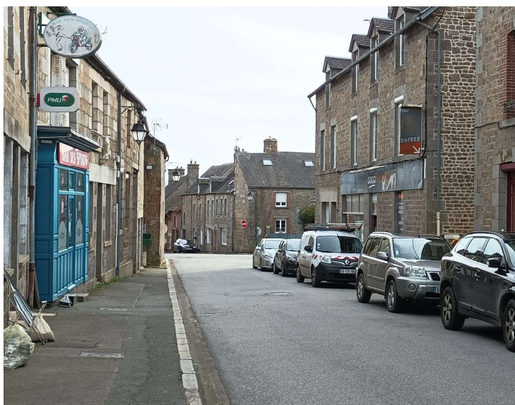
(à gauche) Des trottoirs inaccessibles pour les piétons sur la rue Saint-Martin, une rue investie par le stationnement - Source : PNRNM
