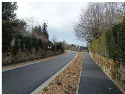
Un patrimoine vernaculaire de murs et murets qui confèrent au bourg son caractère rural, ici sur la traversée de la D908 - Source : PNRNM
