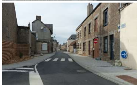
Le réaménagement de la traverse (D908), un exemple de travaux ayant permis d'élargir les trottoirs et d'aménager des espaces de repos - Source : PNRNM
